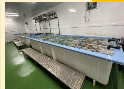
高密度で真鯛の畜養を目的として設置した水槽の例
